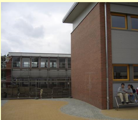
Das Gymei während der Renovierung
